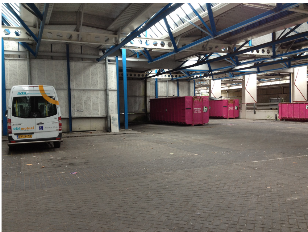
Foto 3, overzicht locatie onder de overkapping
