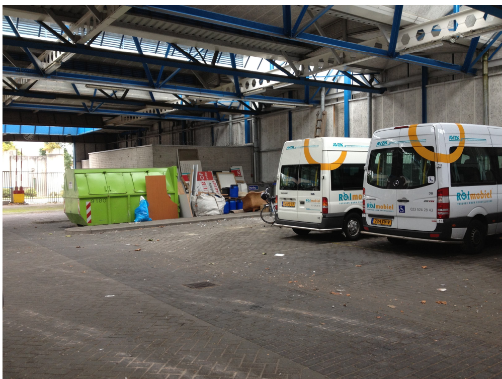
Foto 4, overzicht locatie onder de overkapping
