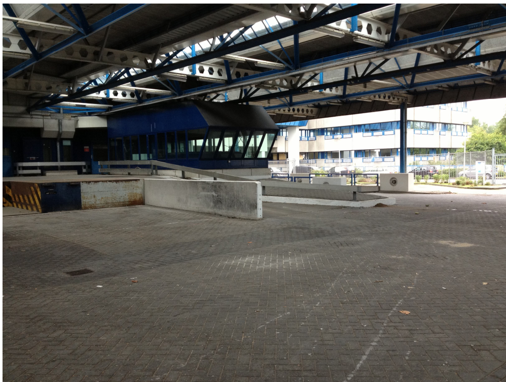
Foto 1, overzicht locatie onder de overkapping
